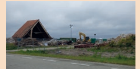
De sloop van de boerderijwoning is bijna een feit.
