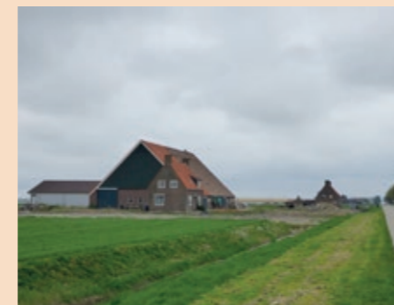
Start van de sloop van een deel van de boerderij.
