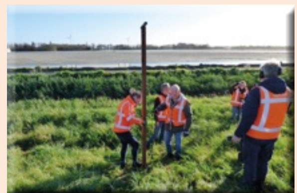
Plaatsen van paal, richten en aanstampen
