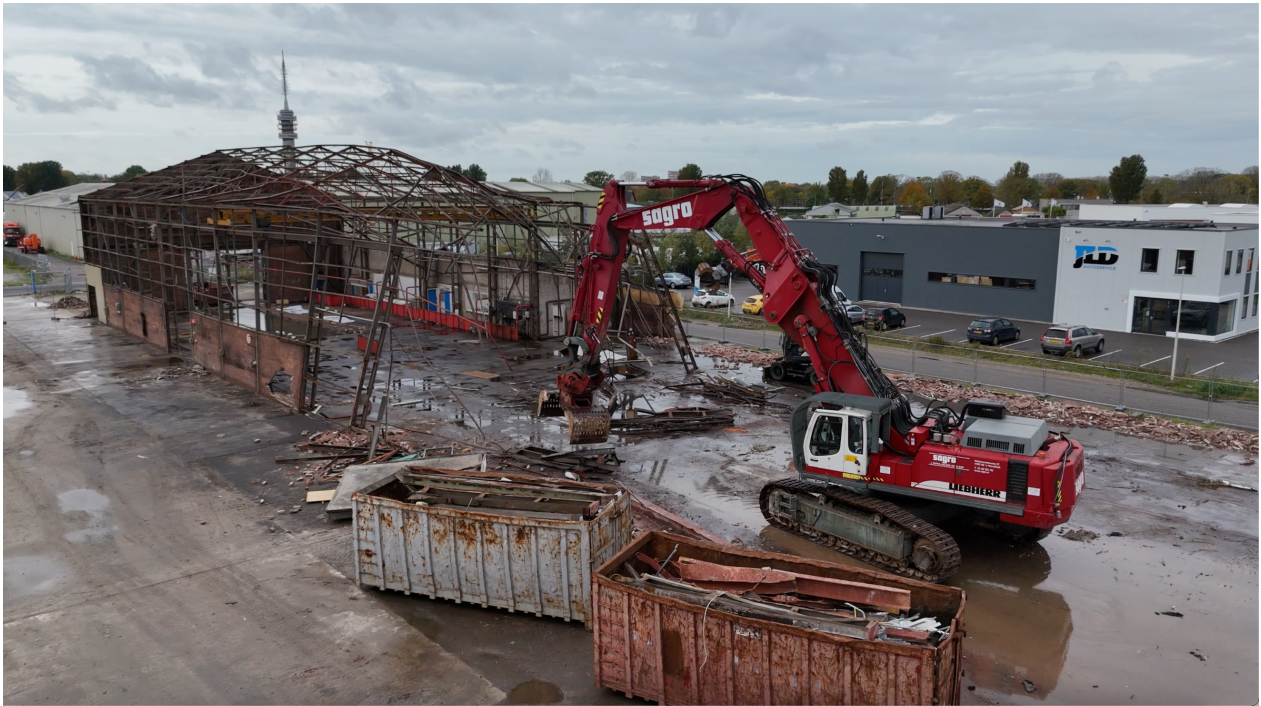
De sloop van een paar loodsen van een voormalige funderingsmachinefabriek in Goes. De mastodont in de voorgrond deed de loodsen in hun geheel bewegen als het een ijzeren balk doormidden knipte. Halverwege de sloop kwam er een kerkuil in een van de overgebleven loodsen bivakkeren...
